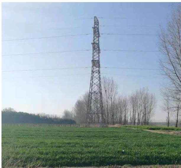
本项目区域内高压线现状照片
