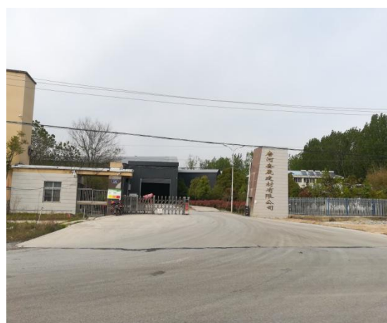
厂区北侧唐河奎晟建材
