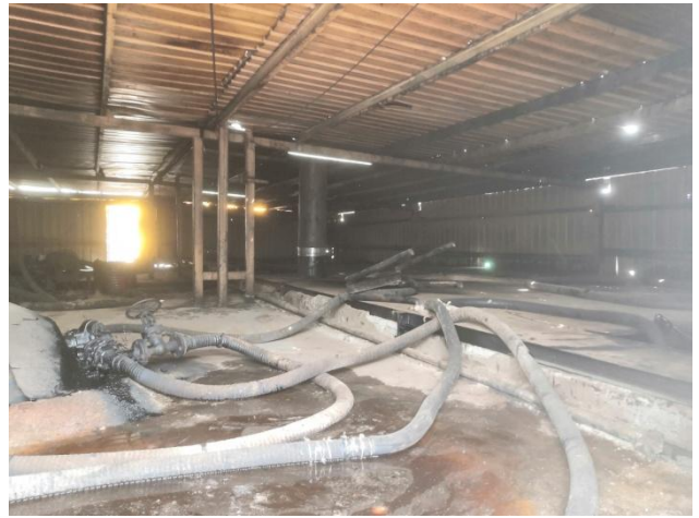
煤焦油收集池
