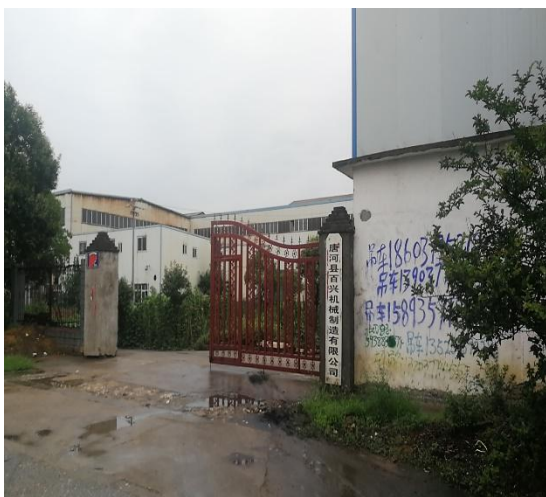
项目东南侧闲置厂区
