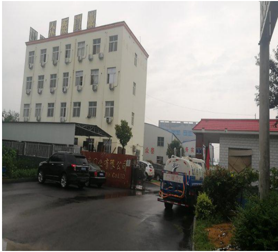
项目厂区大门
