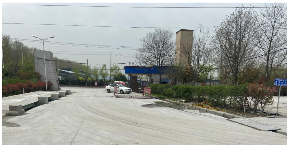
附图五（二） 厂区大门、车辆冲洗沉淀池现状图
