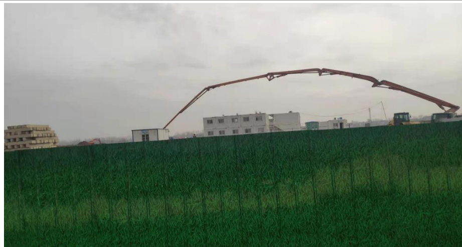
西北侧在建垃圾发电站
