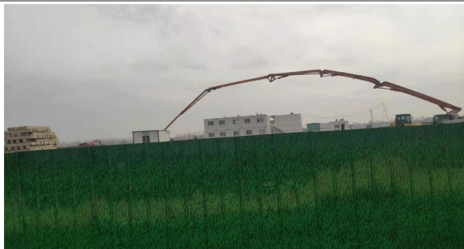
西北侧在建垃圾发电站
