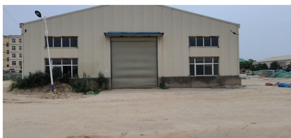
厂区南侧厂房
