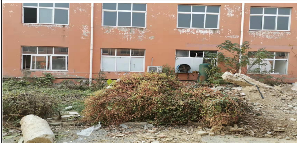
项目南侧空置厂房
