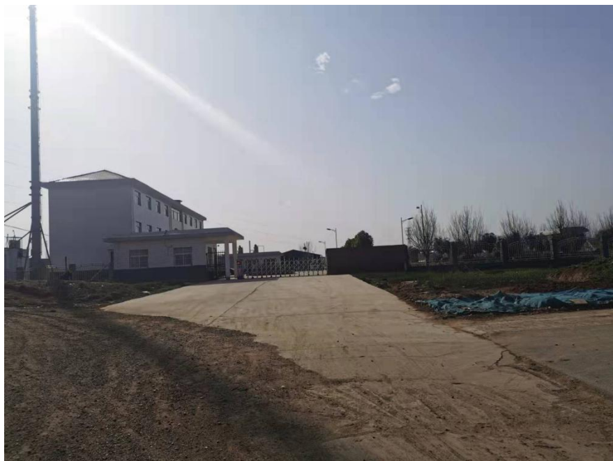
唐河县河西污水处理厂
