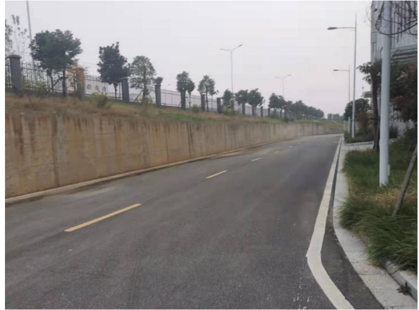
2号厂房东侧道路
