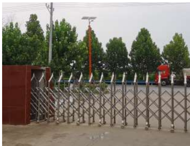
项目厂区北侧 G312 国道
