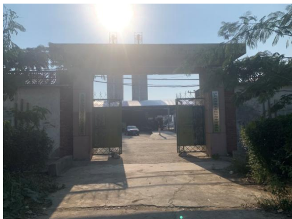
项目租赁厂区现状
