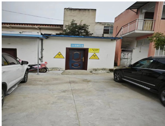
医疗废物暂存间
