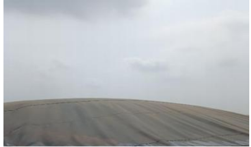
北侧黑膜沼气池
