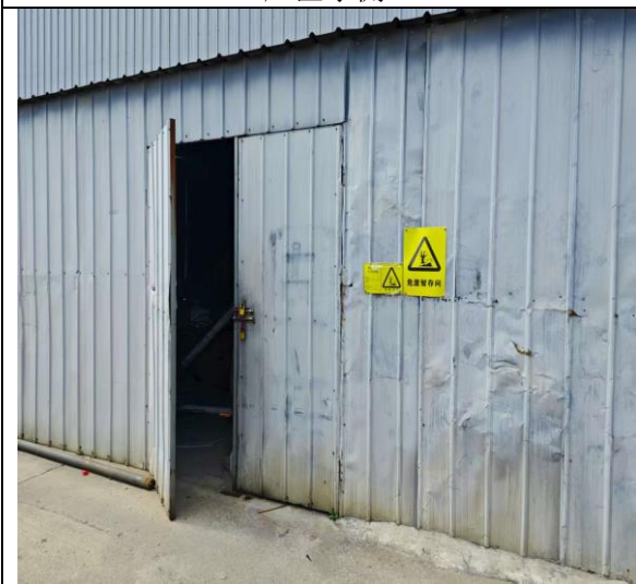
厂区危废暂存间
