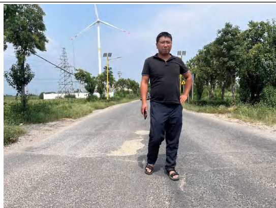
项目 A 段起点现状
