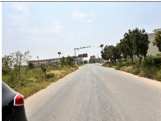
虎山水库水源地路段现状
