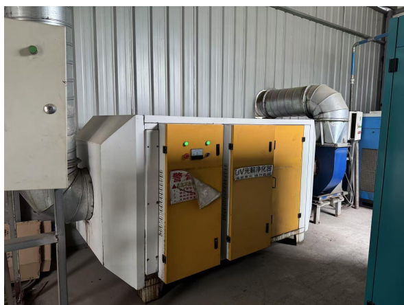
项目现有工程有机废气治理设施
