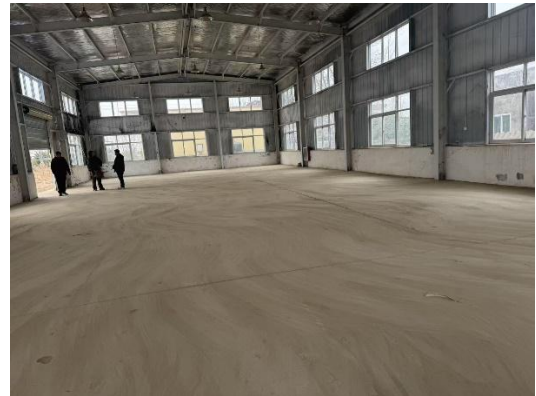
本项目生产车间现状
