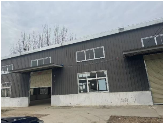
现有厂区生产车间现状
