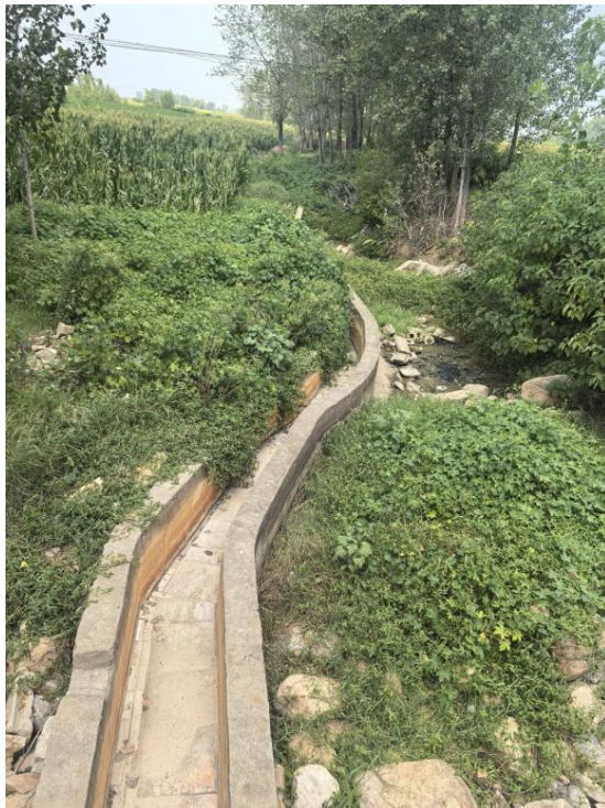
原厂区外排污线路（已停用）
